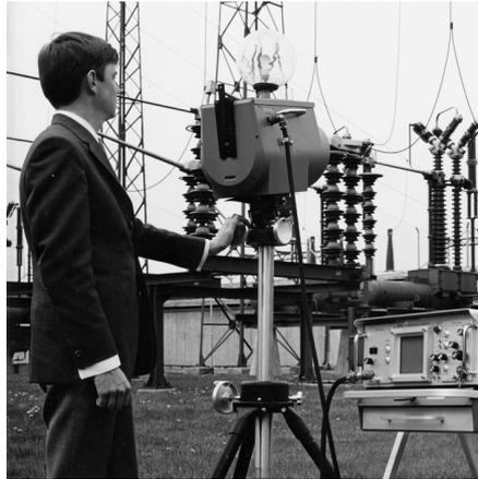
**Figura 14.2** 1969: Thermovision Modello 661. La termocamera pesava circa 25 kg, l'oscilloscopio 20 kg e lo stativo 15 kg. L'operatore inoltre doveva procurarsi un gruppo elettrogeno da 220 VCA ed un contenitore da 10 litri con azoto liquido. Alla sinistra dell'oscilloscopio è visibile l'attacco Polaroid (6 kg).
