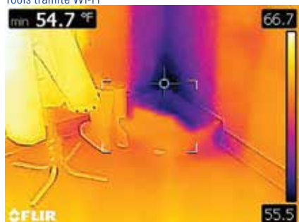
Riquadro con punto freddo che indica un'infiltrazione d'aria
