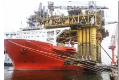
Super-levage et pose synchronisés
