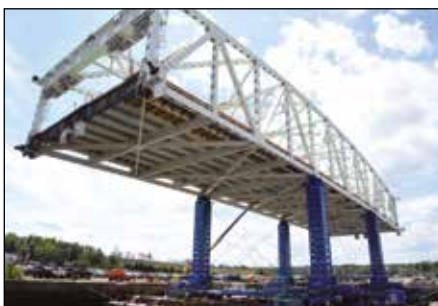
Levage progressif de pont
