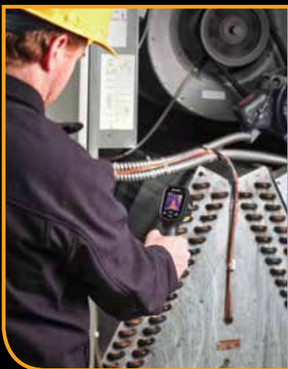
Inspection du système de chauffage, de ventilation et de climatisation
