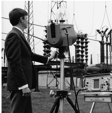
**Figure 13.2** 1969 : Thermovision, modèle 661. La caméra pesait environ 25 kg, l'oscilloscope 20 kg et le trépied 15 kg. L'opérateur avait également besoin d'un groupe électrogène de 220 VCA et d'un récipient contenant 10 l d'azote liquide. À gauche de l'oscilloscope, on distingue le Polaroid (6 kg).
